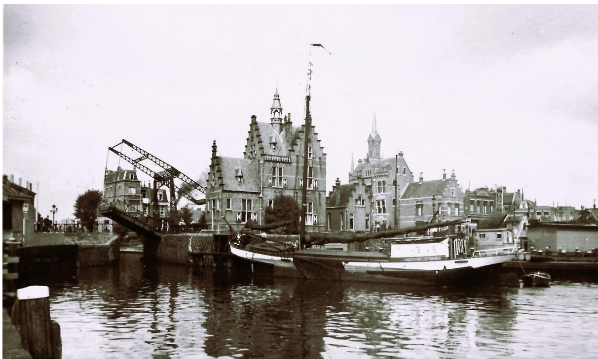
Een klipper vaart de toegang naar de Grootte of Hondsbosche sluis en moet eerst de 'kleine' Wilhelminabrug passeren. Is het schip de brug eenmaal gepasseerd zal de mast gestereken moeten worden om verder te varen want over de Grootte Sluis ligt een vaste brug.
